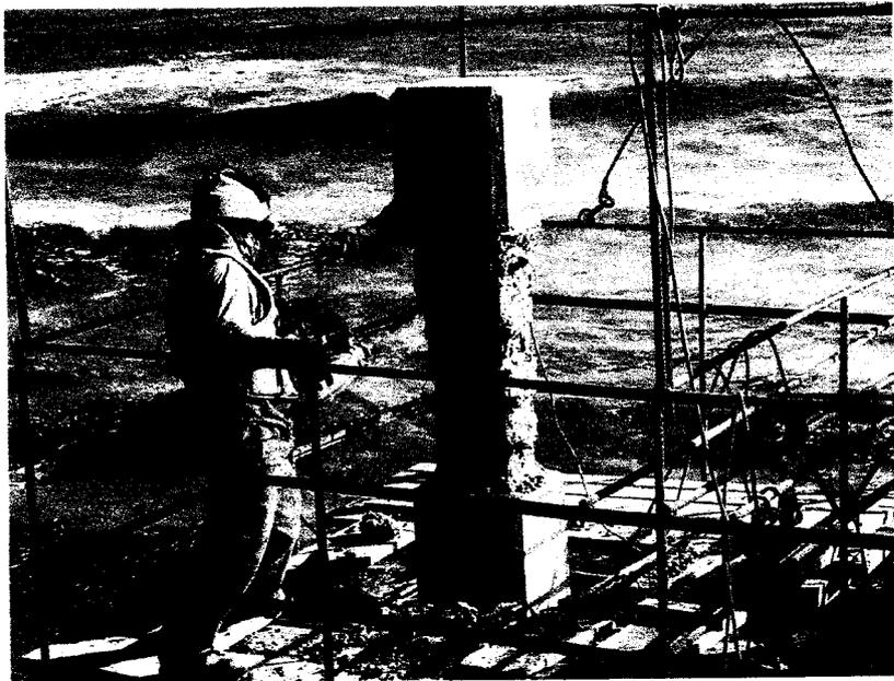
Imagen N°02.- Descabezado de pilotes.
