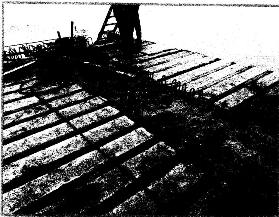
CONCRETO, ENCOFRADO Y A CERO EN JUNTAS LONGITUDINALES
